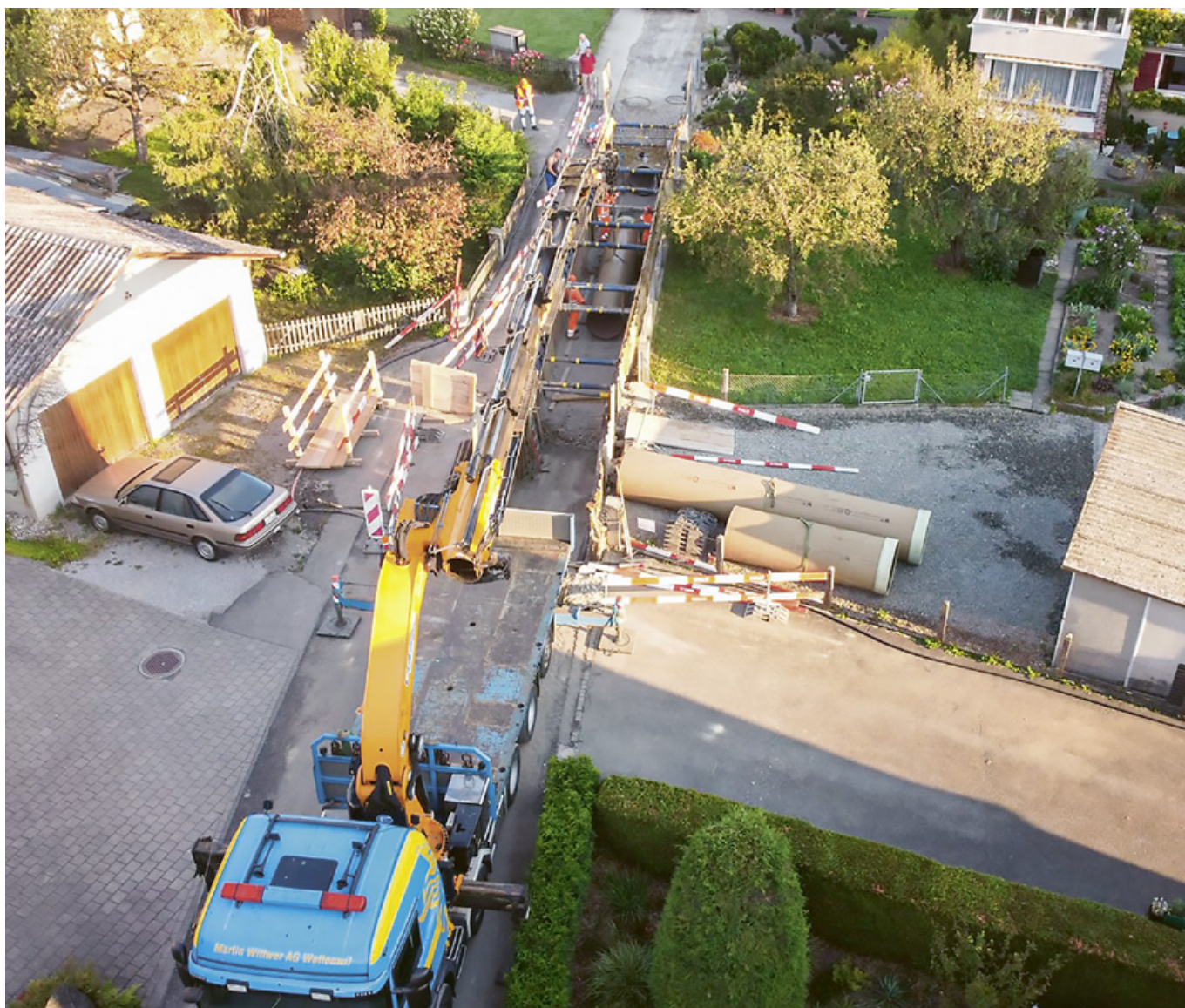
Sanierung Niesenstrasse aus der Vogelperspektive.
