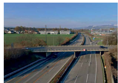
Brücke der Weststrasse (Anschluss Thun-Süd)
