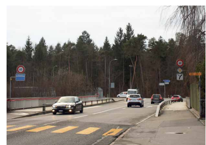
Brücke der Allmendstrasse (Zollhaus)
