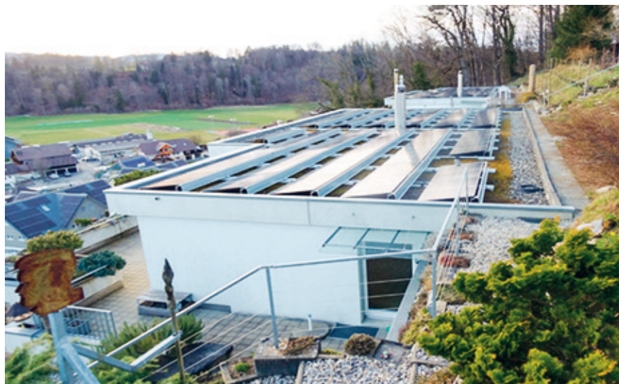
Solarpaneele auf den Flachdächern am Räbbärg.
