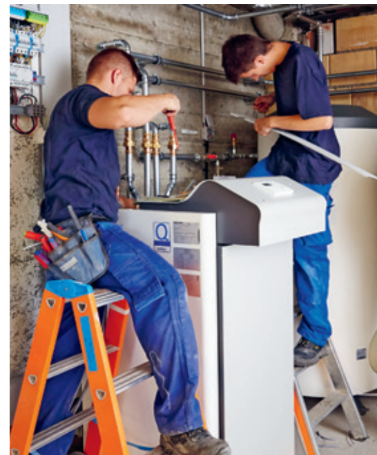
Wärmepumpeninstallateure «in Action».
