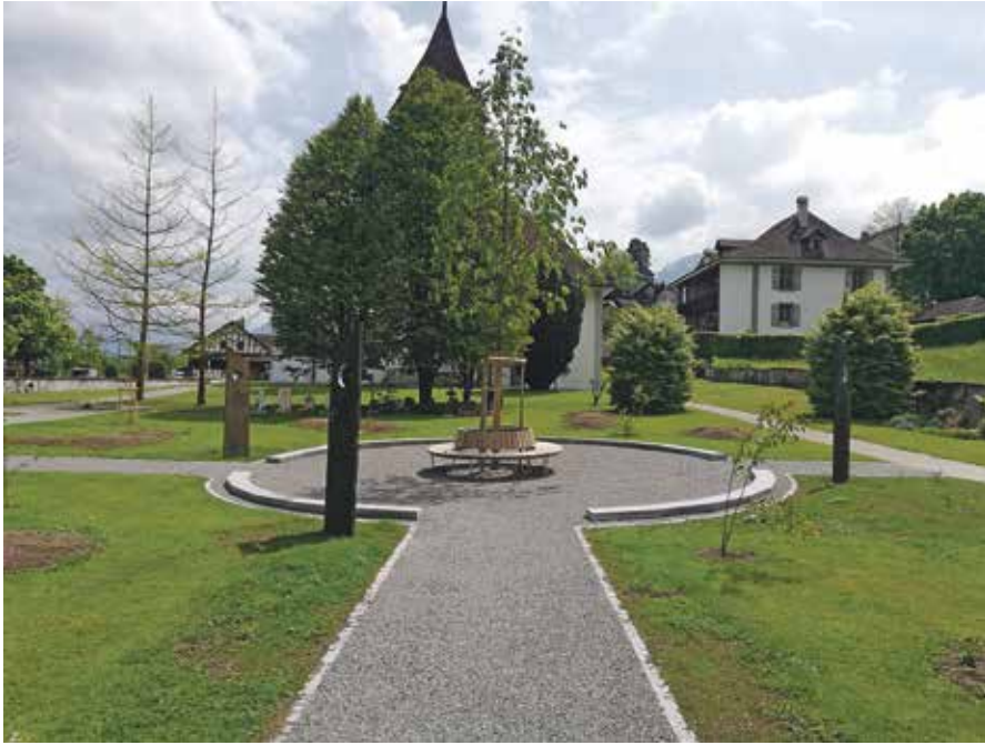
In den letzten Wochen wurden die Bauarbeiten zum neuen Gemeinschaftsgrab abgeschlossen. Auch die Bepflanzung nimmt Form an. Die neue Rundbank um die Linde im Zentrum der neuen Anlage lädt zum Verweilen ein.
