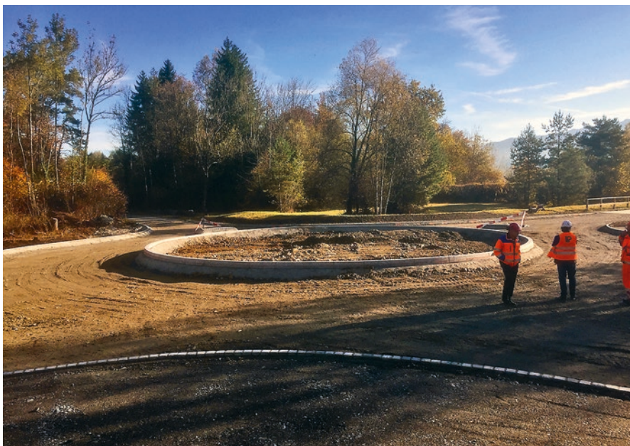
Die Bauarbeiten kommen gut voran.
